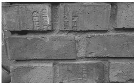
стіна будинку 37-В по Берестейському проспекту, клейма Бучанського цегляного заводу
