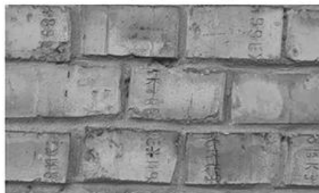
стіна 16-го корпусу, клейма Ірнінського цегляного заводу
